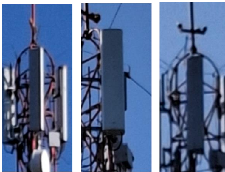
Слика 3.2. Антенски систем предметне РБС (редом по секторима C-S1 ÷ C-S3)
